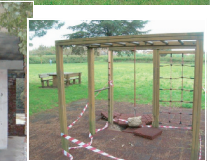
ABBANDONO Due immagini dell'area verde lungo l'argine a Riglione con i giochi e i tavolini fuori uso e, a sinistra, il parco semi-distrutto della Cittadella
